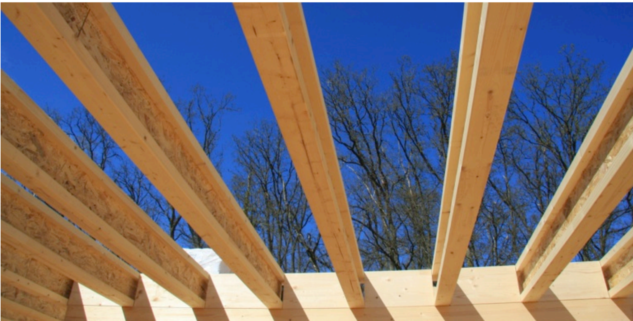
une poutre en I en bois possède une excellente résistance à la flexion, pour un poids minimum.
