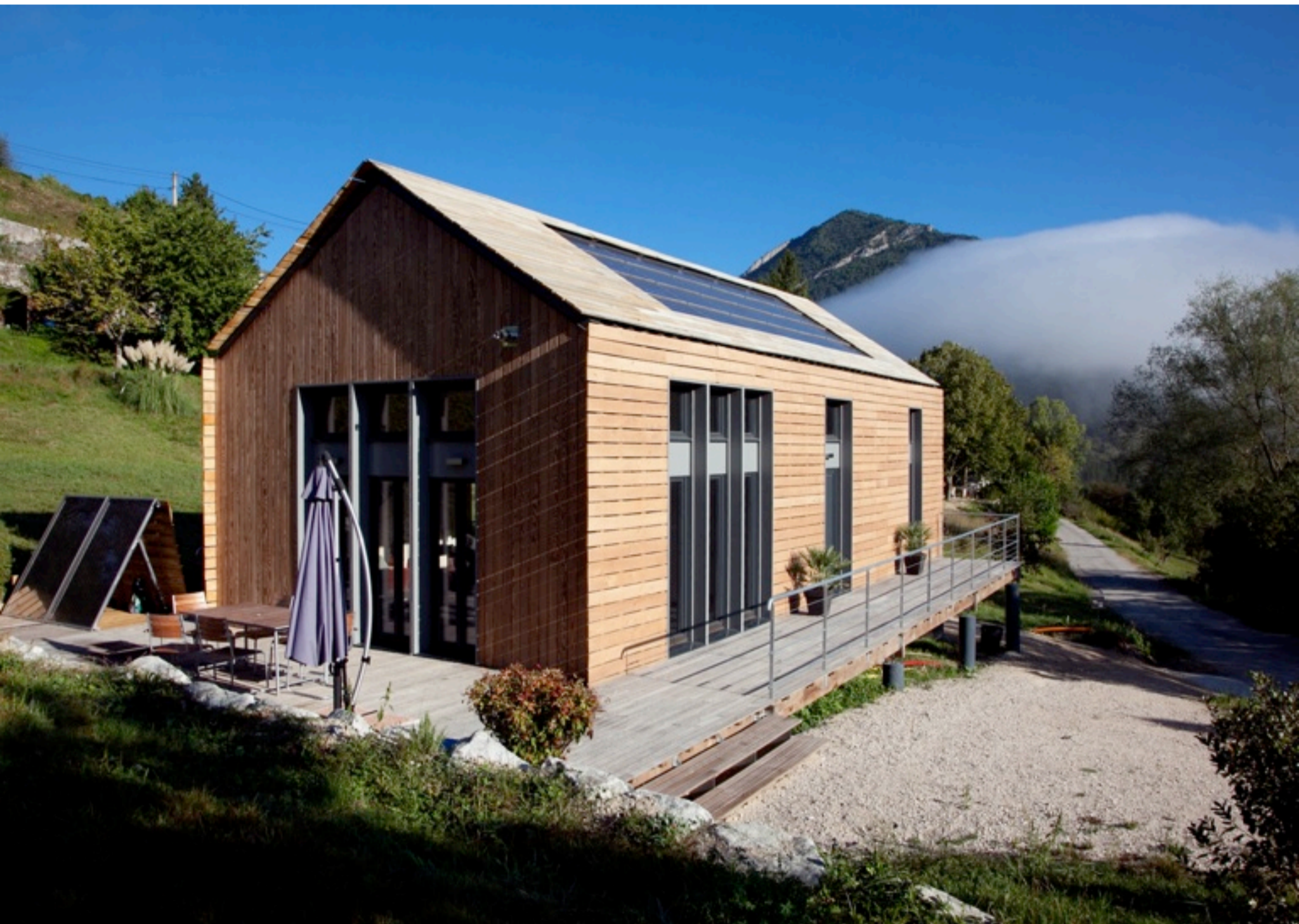
la maison témoin Homelib d'Espenel dans la Drôme est montée sur plots béton
