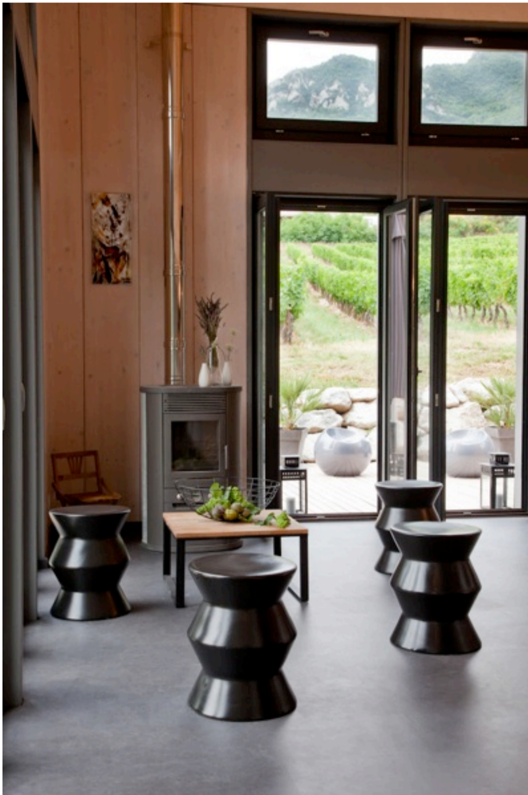
un simple poêle à granulés suffit à chauffer une maison BBC de 150 m2 sur 2 niveaux.
