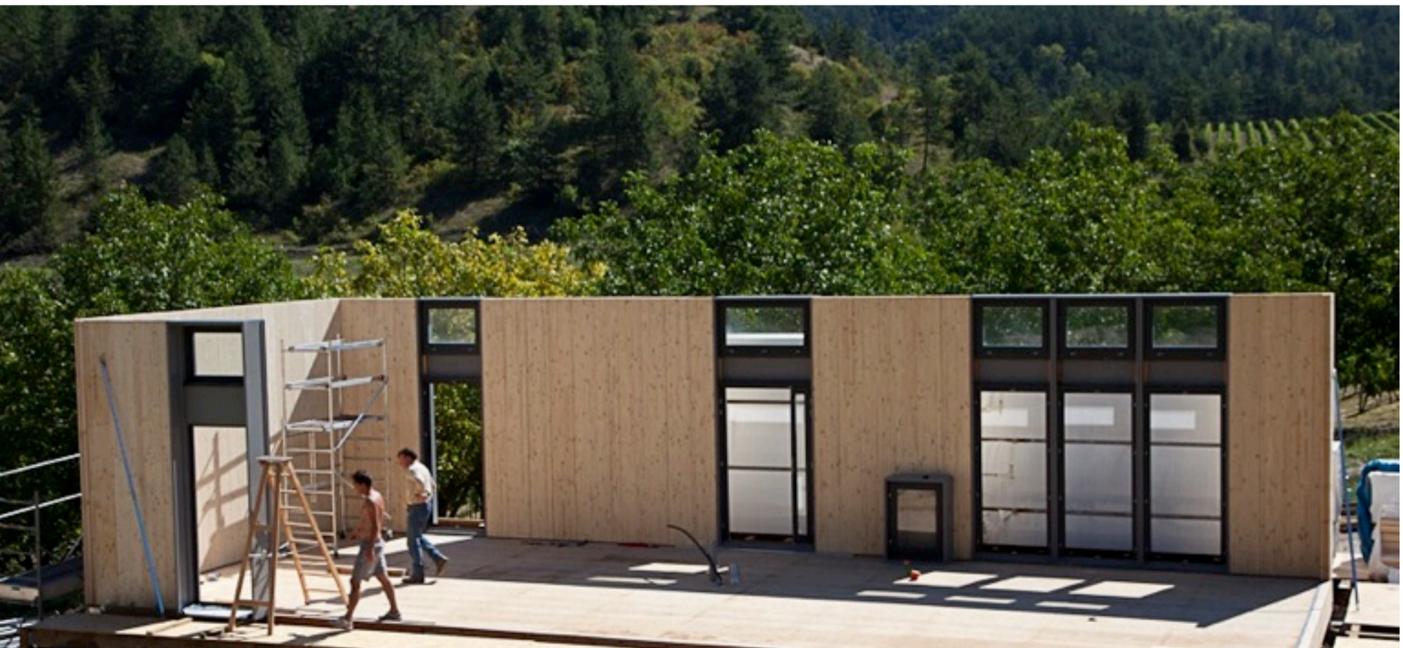
un des gros avantages du bois massif : dès les murs extérieurs posés, l'intérieur est habitable (ici montage de la maison témoin homelib d'Espenel - 26)
