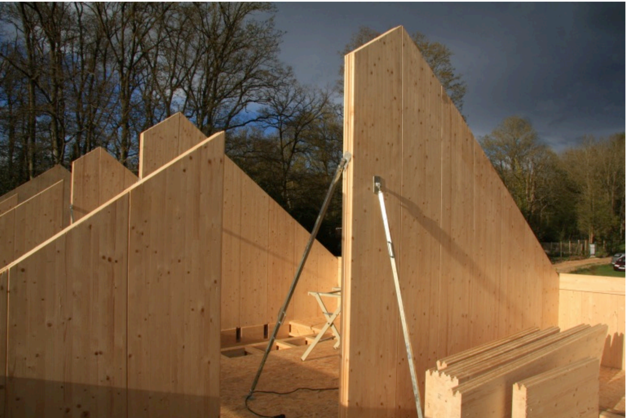
montage de la structure en bois lamellé collé de l'étage de la maison témoin homelib de Raizeux (78)
