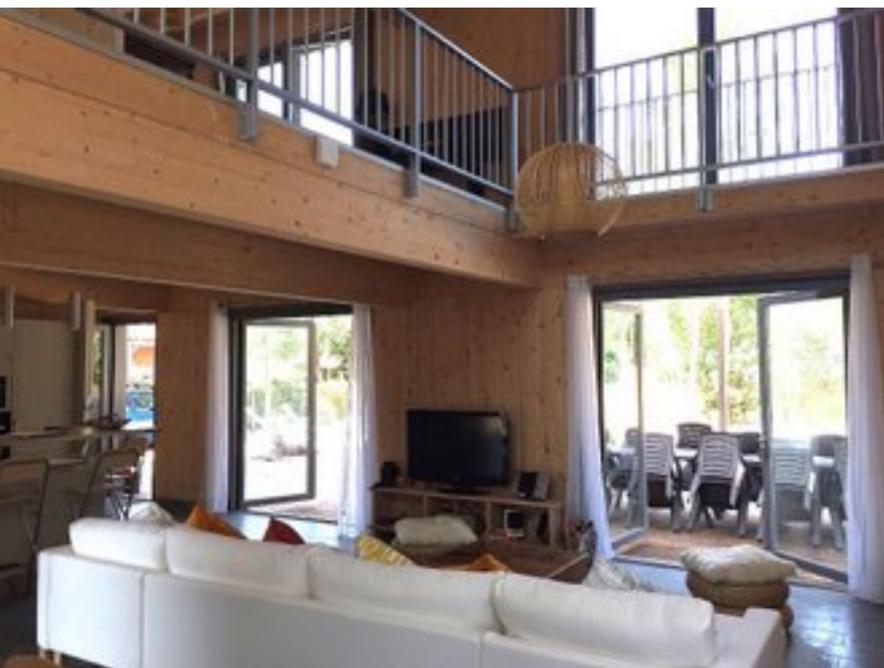
Reposant sur un concept largement répandu en Allemagne, la construction d'une maison en panneaux de bois massif présente de nombreux avantages : isolation par l'extérieur limitant les ponts thermiques, étanchéité à l'air naturellement efficace, excellente acoustique, régulation hygrométrique.
