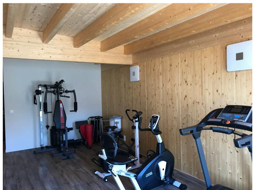
*exemple cabinet de kiné à Camiers (62) : pose des panneaux 3 plis sur les solives BLC, puis fibre de bois, puis pare pluie la sous face en panneaux 3 plis reste apparente. Le panneau 3 plis fait office de pare vapeur.*
