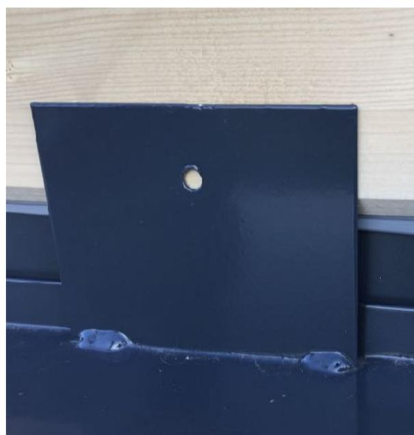
*La fixation du pré-cadre dans les murs se fait par l'intermédiaire d'une patte soudée*
