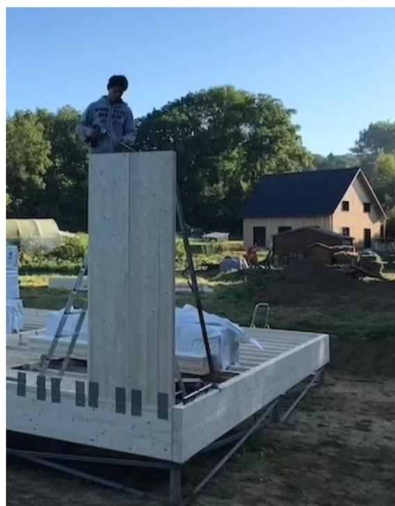
*fixation de panneaux de murs BLC sur lisses basses ou porteurs de dalle plancher, par plaques métalliques*
