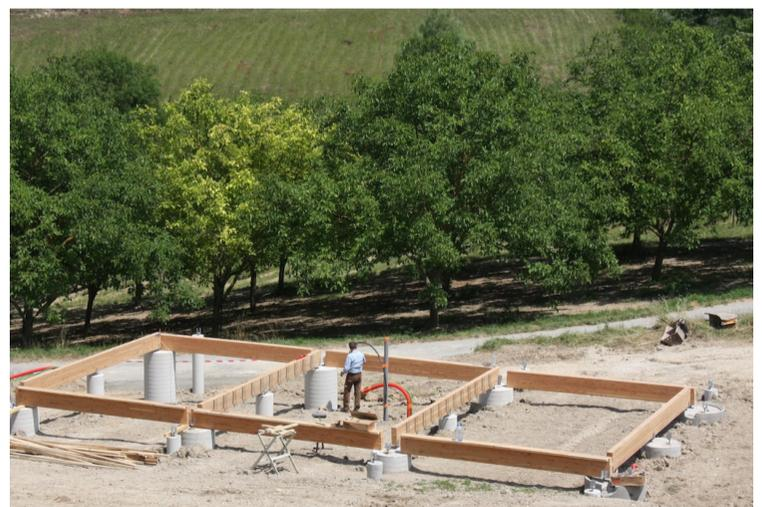
*plots béton pour recevoir une dalle plancher
