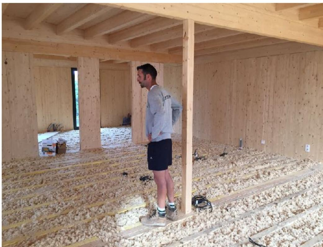
*faux plancher technique posé sur dalle plancher : isolation par fibre de bois en vrac*
