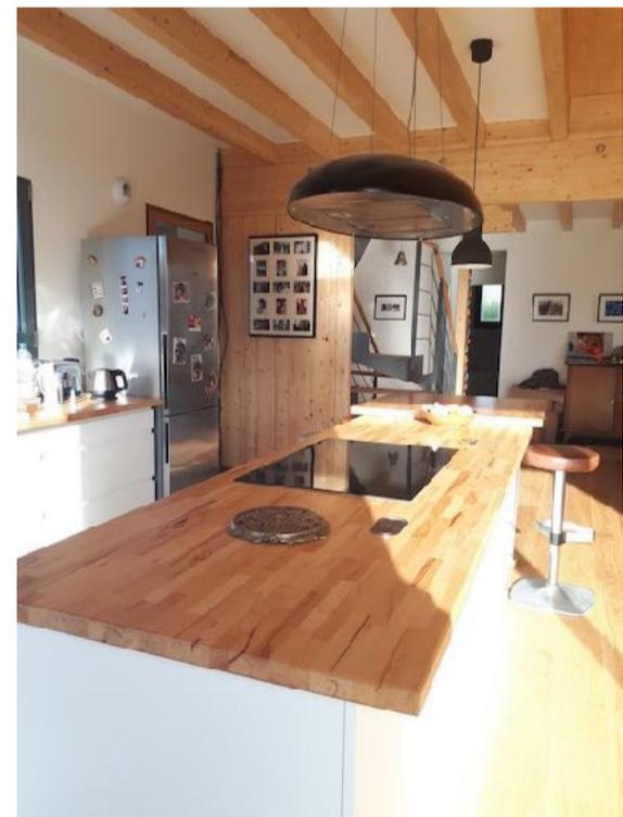
*sous face plancher intermédiaire avec solives BLC + panneaux 3 plis / variante sous face en « placo » au dessus de la cuisine*
