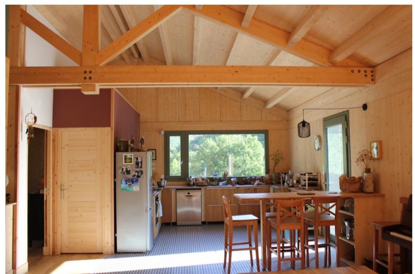
*exemple maison Saou (26) : pose des panneaux 3 plis sur les solives BLC, puis pare vapeur, puis fibre de bois, puis pare pluie ; la sous face en panneaux 3 plis reste apparente*
