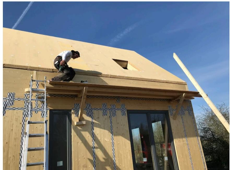
*pose de panneaux MFP sur les pannes BLC, puis fibre de bois rigide + pare pluie ; par l'intérieur, pose de fibre de bois flexible entre pannes ; puis pose pare vapeur au dessous, puis pose parement intérieur (placo, lambris, ou autre..)*
