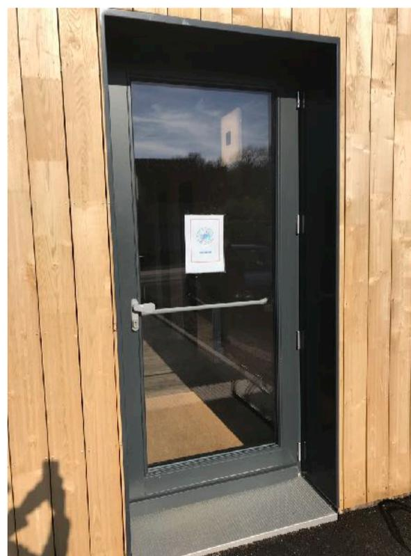
*pré-cadre avec ajout d'une tôle « larmée » sur la planche de seuil*
